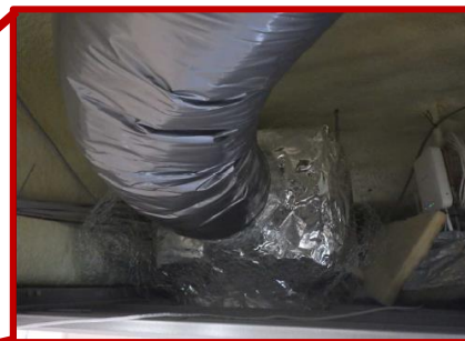
保温材を巻いた給気ダクト（施工後）
