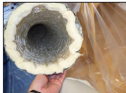
給気ダクトにも保温付きフレキシブルダクト（※）を用いました ※保温材（写真、白い部分）が巻き付けられたダクト
